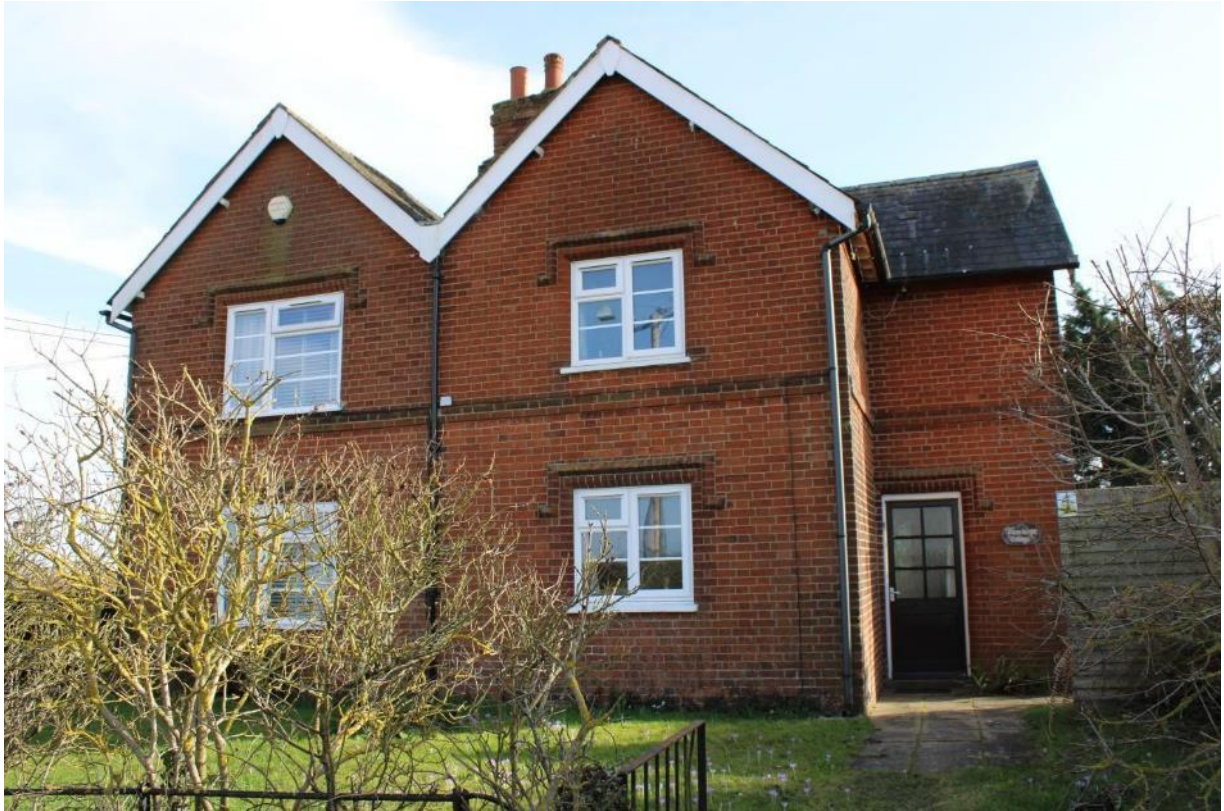
Vicarage Cottages, Vicarage Lane
